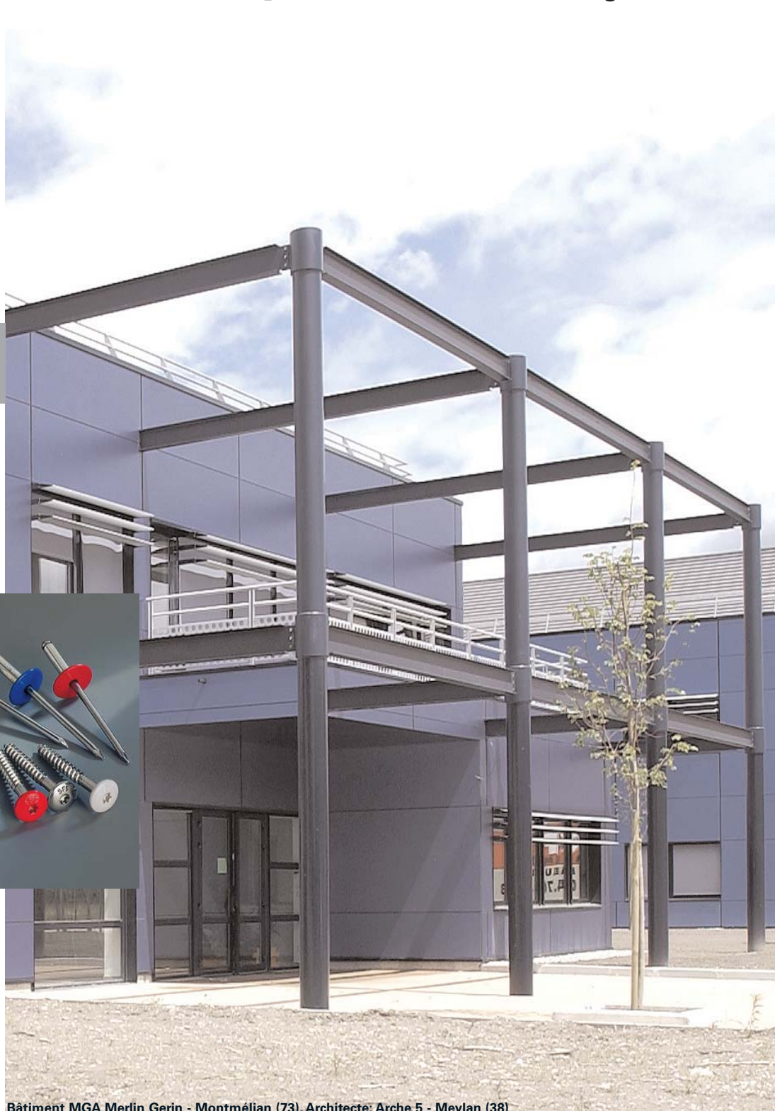
Bâtiment MGA Merlin Gerin - Montmélian (73), Architecte: Arche 5 - Meylan (38)
